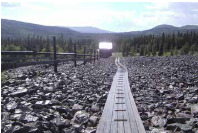
Stånggången från Spelhuset till pumpen i Drottningsschaktet.
