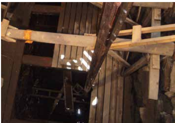
Drottningsschaktet. Vattenpumpen som drivs av Stånggången.
