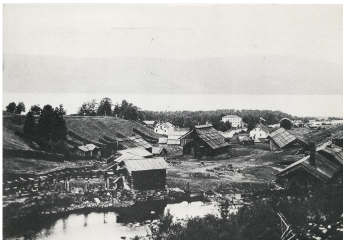
Huså Bruk 1896. Foto: Järnvägmuseet
