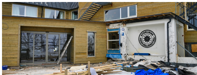
Den nya entrén är inte helt färdig ännu.
